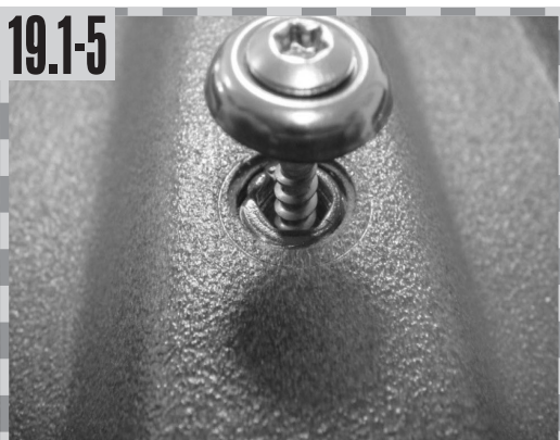
Spenglerschraube setzen...
